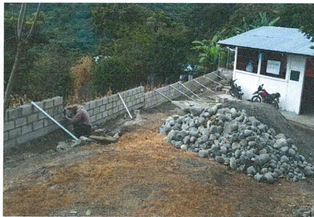
Foto 2: Mejoramiento del cerco perimetral.
