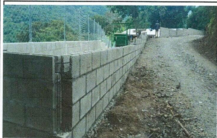
Foto 3: Mejoramiento del cerco perimetral
