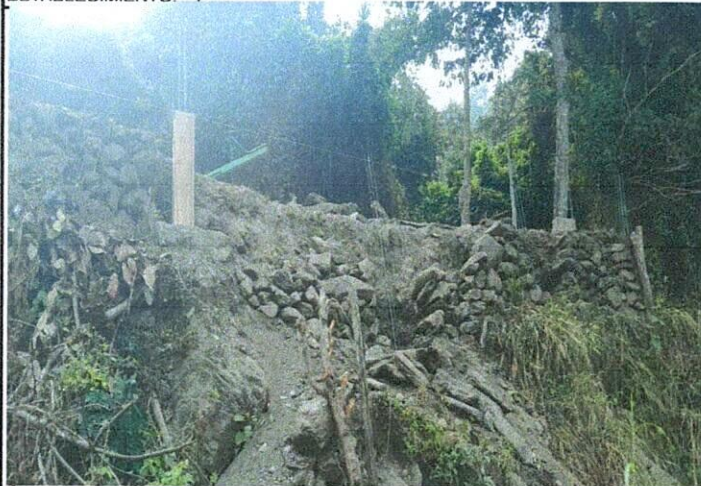
Foto 1: Mejoramiento del cerco perimetral.
