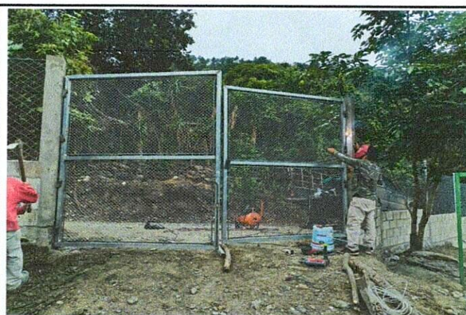
Foto 4: Mejoramiento del portón
